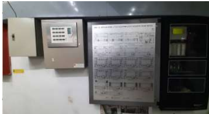
ภาพที่ 5-24 ศูนย์ควบคุมการรับส่งสัญญาณแจ้งเหตุเพลิงไหม้
