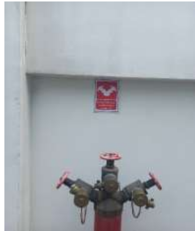
ภาพที่ 5-21 หัวรับน้ำดับเพลิงจากภายนอกอาคาร
